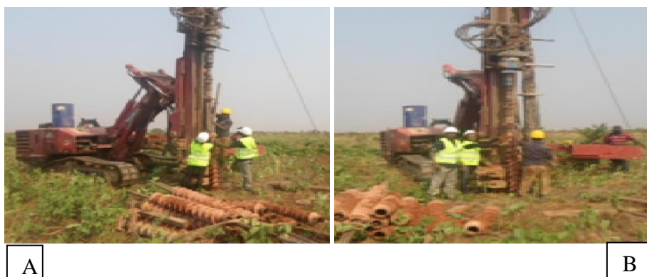
Figura 2: A) Montando o trado; B) Avanço da perfuração. Fonte autor
