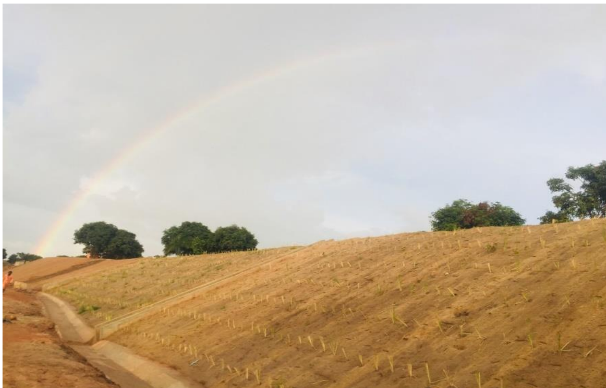
Figura 8. Estaqueamento e plantio com bambus.
