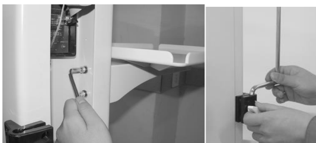
Figura 6. Instalando a prateleira e a haste I.V
